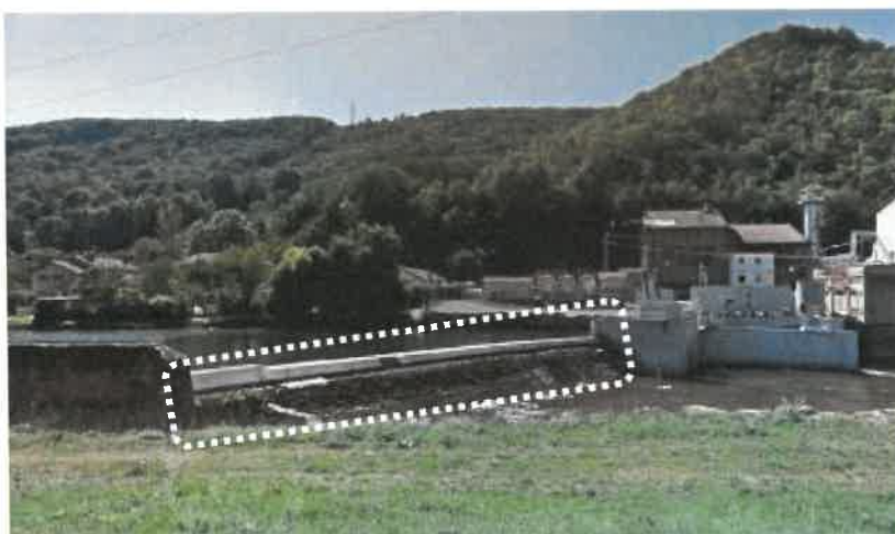
Figure 566 : barrage de La Mourlasse sur le Salat à Eycheil-Encourtiech avec sa rehausse visible en crête
