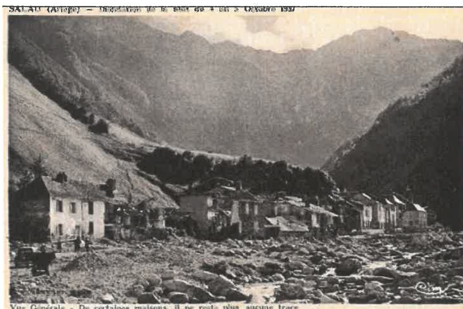
Figure 15 : prise de vue des dégâts de la crue des 4 et 5 octobre 1937 à Salau
