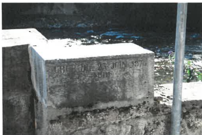
Figure 599 : marque de la crue du 23 juin 1875 gravée au pont Neuf de Saint-Girons
