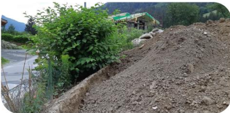
Stockage de matériaux sans précaution sur un massif de renouée - photo ©Aqubio
