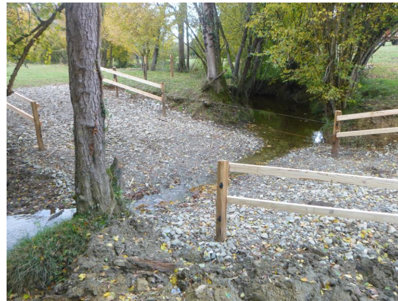
Aménagement d'un gué sur le Rieumajou
