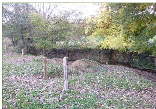
Pose de clôture sur le Rieumajou
