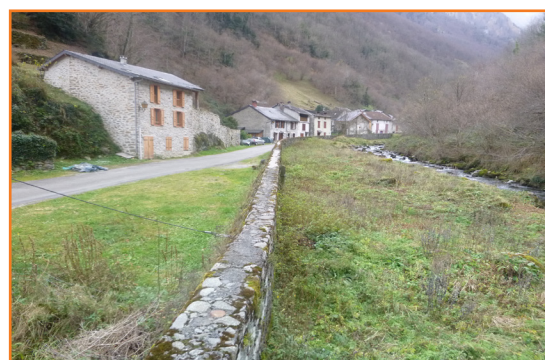
Mur digue de Salau construit après l'inondation de 1982
