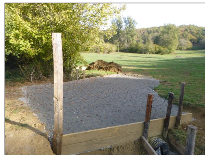
Aménagement d'une aire stabilisée sur une affluent-source du Rieumajou
