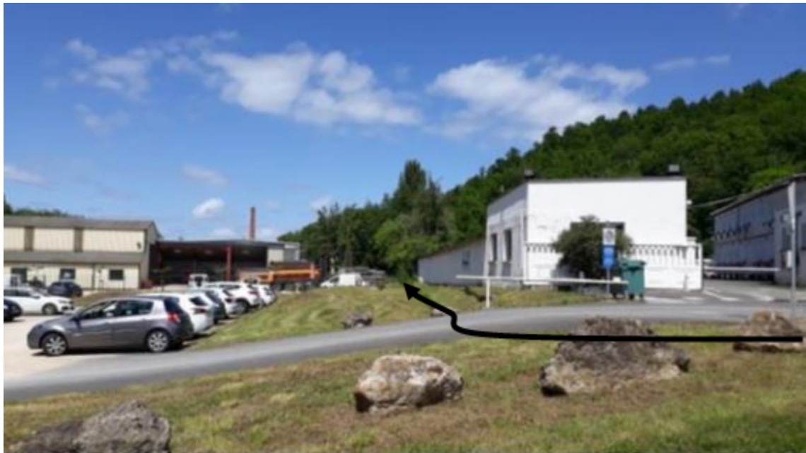
Figure 62 : vue du ruisseau St-Vincent dévié via un fossé perché
