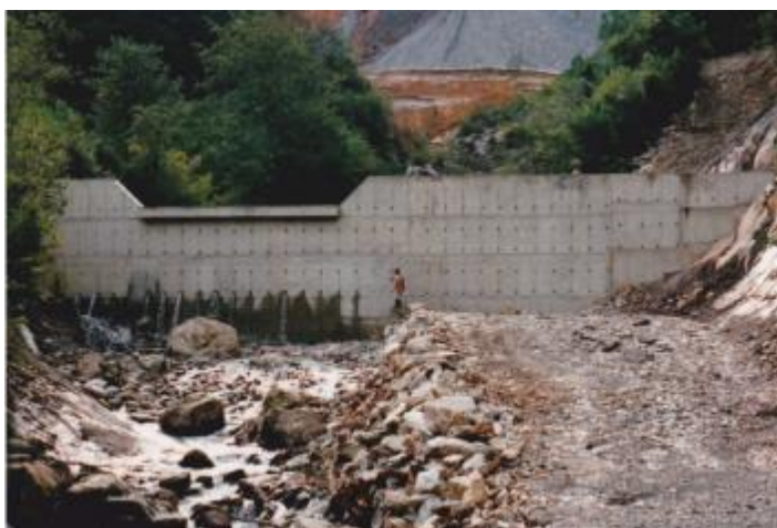
Figure 55 : barrage des Cougnets vu de l'aval
