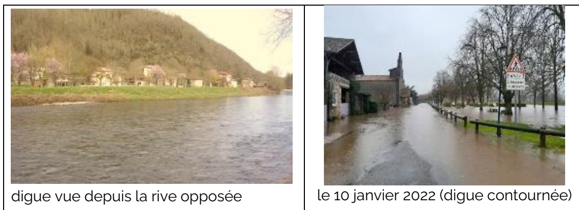
Figure 43 : digue et hameau de Bonrepaux
