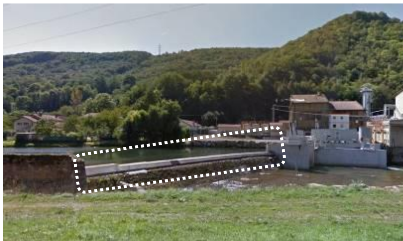
Figure 54 : barrage de La Moulasse sur le Salat à Eycheil-Encourtiech avec sa rehausse visible en crête
