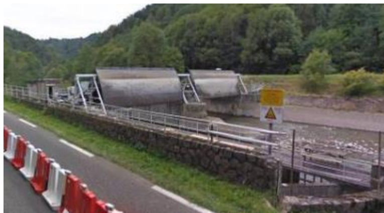
Figure 56 : barrage de Quercabanac sur le Salat à Soueix-Rogalle avec ses 2 vannes secteurs visibles
