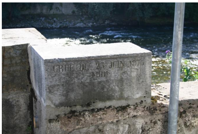
Figure 1 : marque de la crue du 23 juin 1875 gravée au pont Neuf de Saint-Girons
