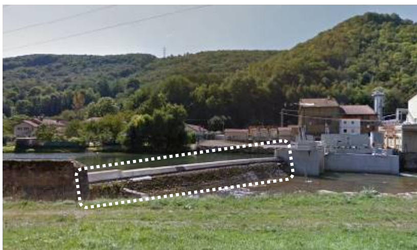
Figure 55 : barrage de La Mourlasse sur le Salat à Eycheil-Encourtiech avec sa rehausse visible en crête
