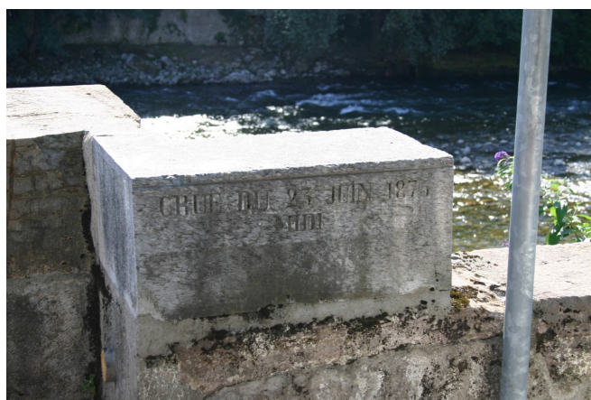
Figure 58 : marque de la crue du 23 juin 1875 gravée au pont Neuf de Saint-Girons
