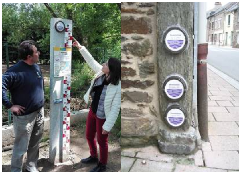
Figure 59 : exemples de repères de crue sur support propre (à gauche, couplé avec échelle et panneau didactique) ou intégrés au bâti (à droite)
