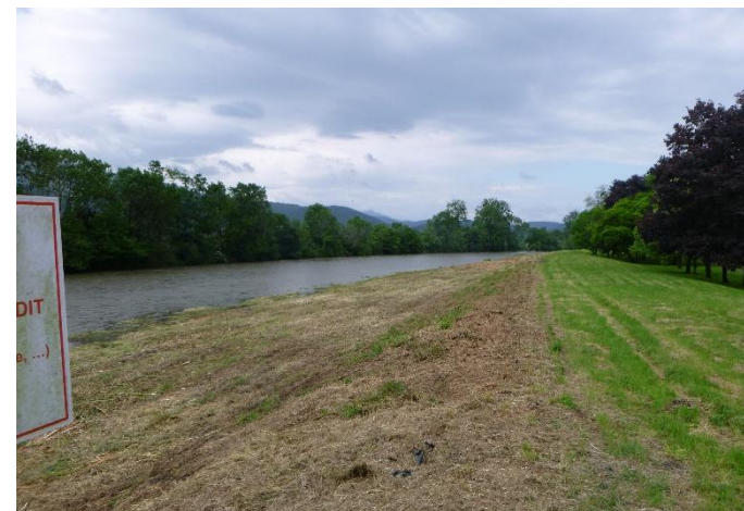
Entretien de la végétation de la digue de Bonrepaux
